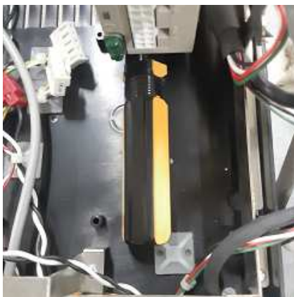
ネジ(下)を外す時の上方から見た状態
